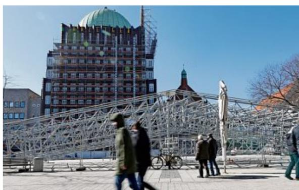
Insgesamt fünf Traversen werden ab nächster Woche die Kuppel des Anzeiger-Hochhauses überspannen.
