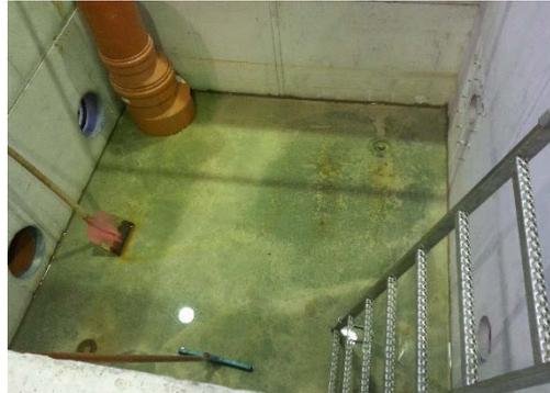
a) Ablaufleitung an rechter Öffnung (v. außen) b) Drosselschacht-Unterteil mit insgesamt vier Öffnungen (2 Zuläufe rechts im Bild, 2 Abläufe links im Bild)
